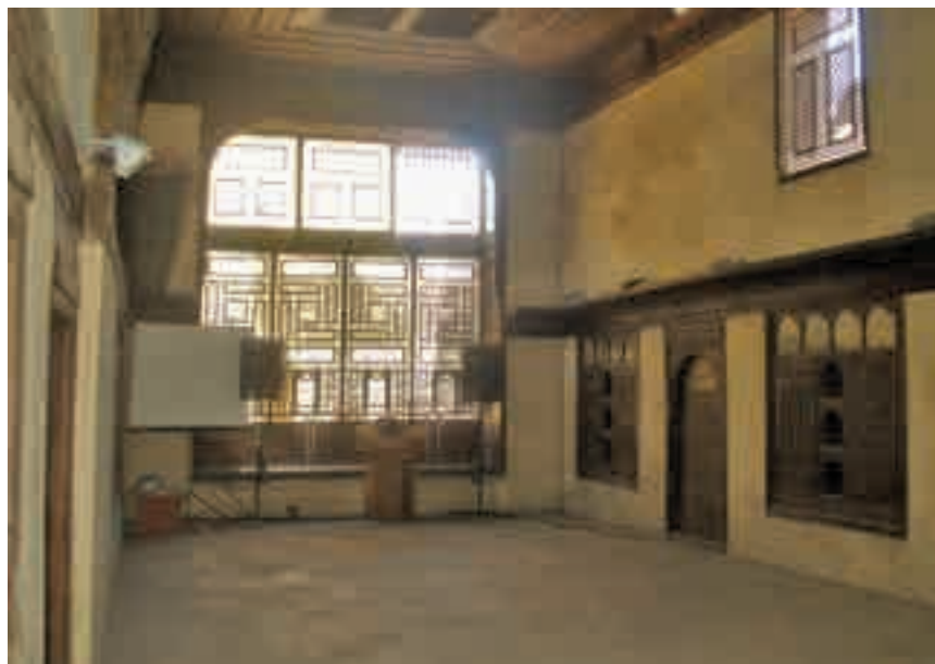
Planche n° 76 : La grande salle, l'iwan, en son front un grand moucharabieh donnant sur l'extérieur. Le mur interne est doté de deux armoires en bois encadrant la porte de la chambre à coucher attenante à la salle.
