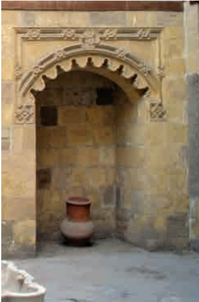
Planche n° 35 : La « maziara » à l'angle est de la cour d'honneur.
