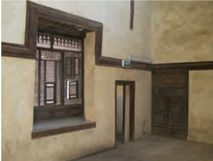
Planche n° 67 : La salle de répartition qui précède la grande salle, l'entrée de la grande salle et la fenêtre recouverte par un paravent en bois tourné donnant sur la « dorqa'a ».
