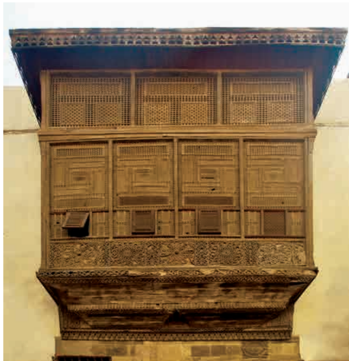
Planches n° 9-10 : Le moucharabieh au-dessus de l'entrée principale, un détail de la marqueterie décorative en bois.
