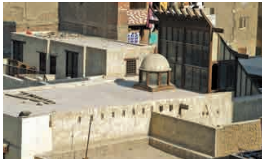
Planche n° 89 : Le plafond de la maison où apparaît le grand « malkaf » et le dôme pour l'aération de la grande salle. A gauche dans la photo, apparaît le petit « malkaf » en bois pour l'aération des chambres et des locaux de la section du harem.
