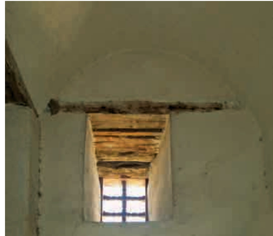
Planche n° 42 : Les locaux de service, le plafond d'un des sièges d'aisances des appartements du harem, avec son étroite fenêtre supérieure qui apparaît.
