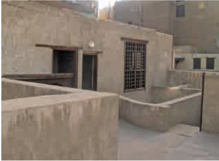
Planche n° 84 : La salle du deuxième étage dans la section du harem sur laquelle s'ouvrent deux chambres. Elle comporte le « malkaf » qui reçoit l'air pour la salle se trouvant au-dessous d'elle au premier étage.
