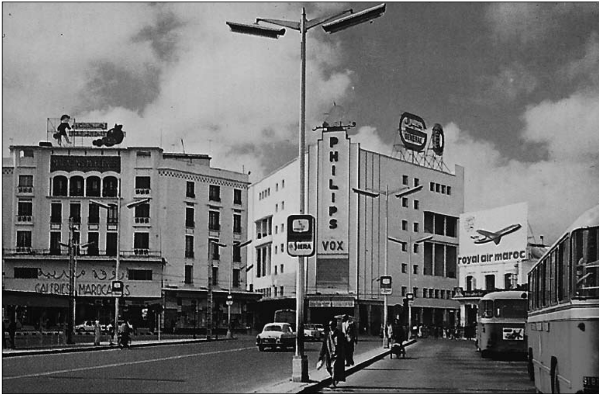
Fig. 3.41 Le cinéma Vox de Marius Boyer et les Galeries marocaines (ex Magasins Paris-Maroc) d'Hyppolite Delaporte et Auguste Perret dans les années 1960, avant leur démolition. © J.-L. Cohen
