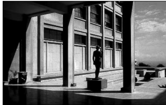
Fig. 1.26 Ecole de Beaux Arts d'Alger, (1950), Claro, architecte © Malverti
