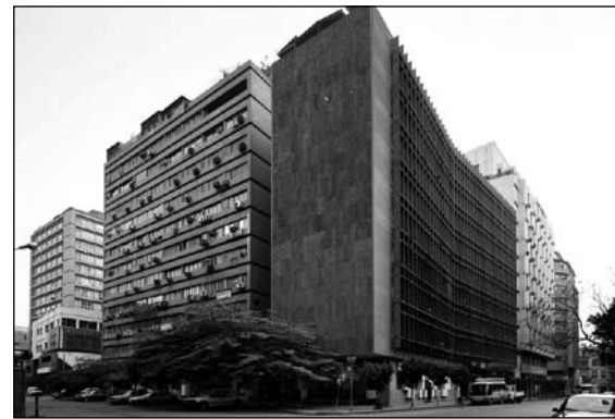
Fig. 2.24 Bâtiments du ministère de la santé, construits sur le site de Shephard. © A. Bonnamy
