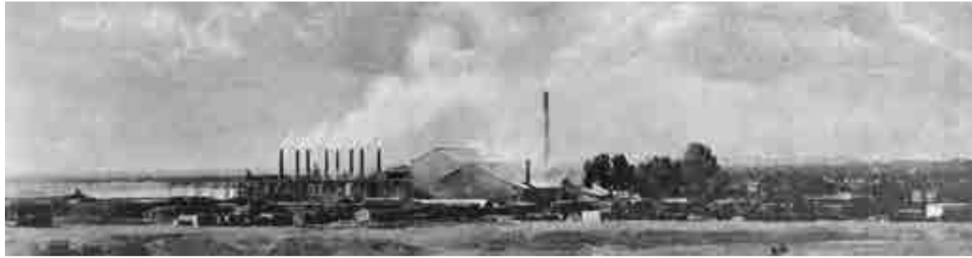
FABRIQUE DE CIMENT DE MAASSARAH.
