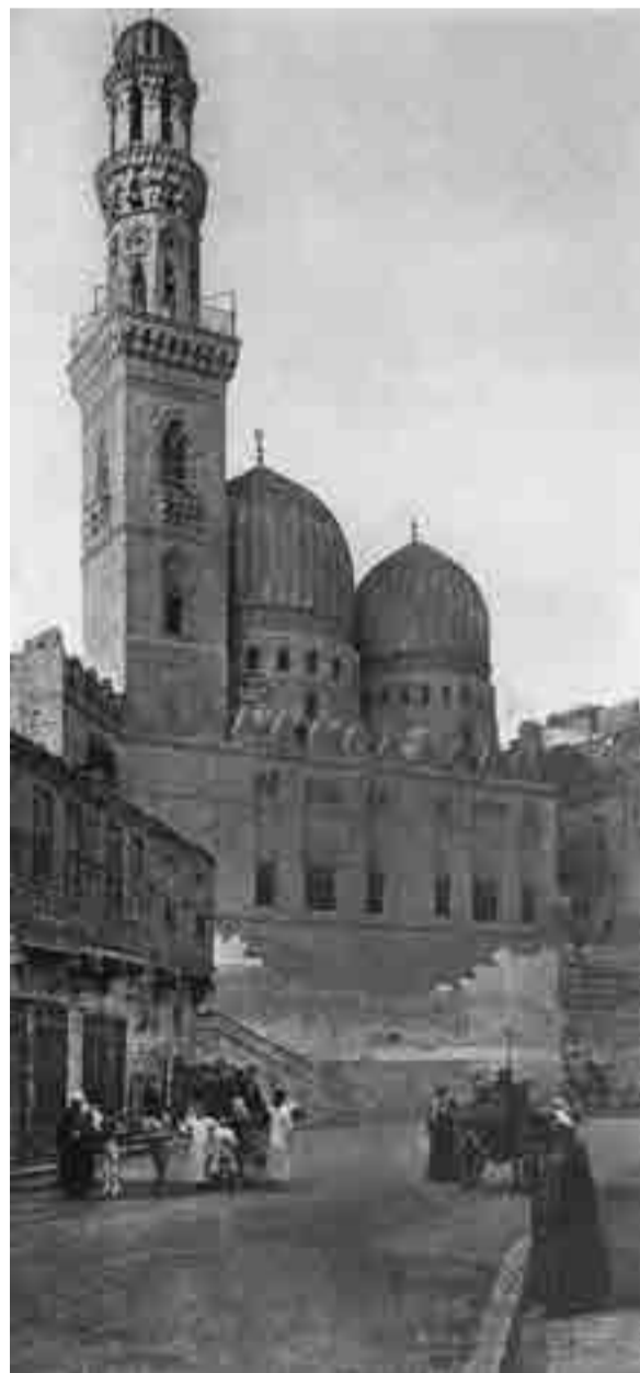
MOSQUÉE SANGAR GAOULI.
